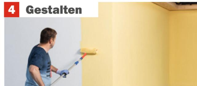
Zunächst wird die Fläche grundiert. Anschließend trägst du deine gewünschte Baumit Endbeschichtung auf.
