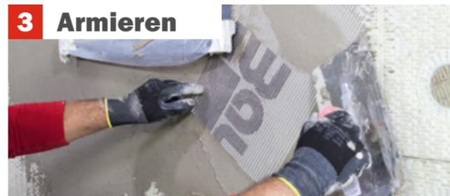
In allen Eckbereichen von Gebäudeöffnungen werden Diagonalarmierungen eingesetzt, um den größtmöglichen Schutz vor Kerbrissen zu bieten. An Außenecken werden PVC-Eckwinkel in den Armierungskleber eingespachtelt. Anschließend flächig das Armierungsgewebe einspachteln, bis dieses nicht mehr zu sehen ist.
