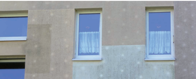
Dübelkopfabzeichnungen durch Verarbeitungsfehler oder falsche Dübelauswahl können nachträglich nicht mehr dauerhaft beseitigt werden.
