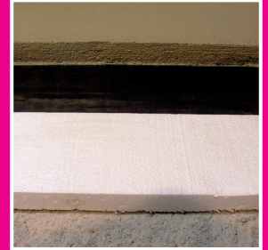
Aufbau „schwimmender“ Estrich
