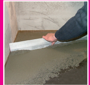
1. Estrich einbringen und verziehen
