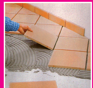
3. Estrich mit Fliesen belegen
