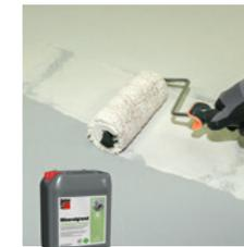
**3** Kalziumsilikatplatte auf der Rückseite grundieren (verdünnt 1:1 mit Wasser) und vollflächig im Verbund verlegen.
