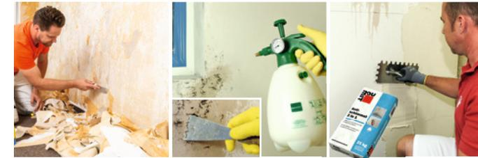
**1** Handelsübliche Peroxidlösung\* aufsprühen, Tapeten/ Putz entfernen. Danach erneut aufsprühen und entfernen.
